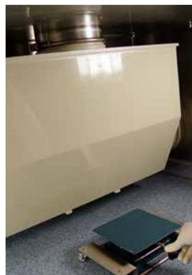
11. Setzen Sie zunächst einen Schutzdeckel auf dem FIBO-Zuluftflansch auf.
