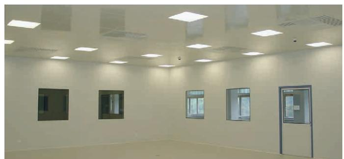
Abbildung 3: Die PIFF Module sind in die Decke des Reinraums integriert
